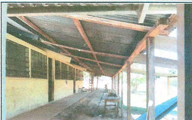
Foto 2: Cambio de estructura de madera a metal
