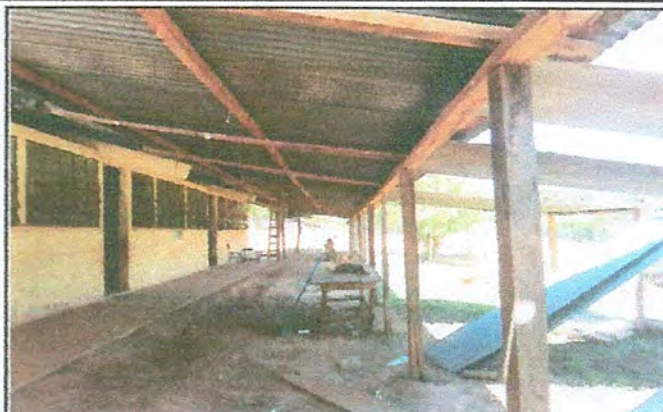
Foto 2: Aplicar losa de piso al patio
