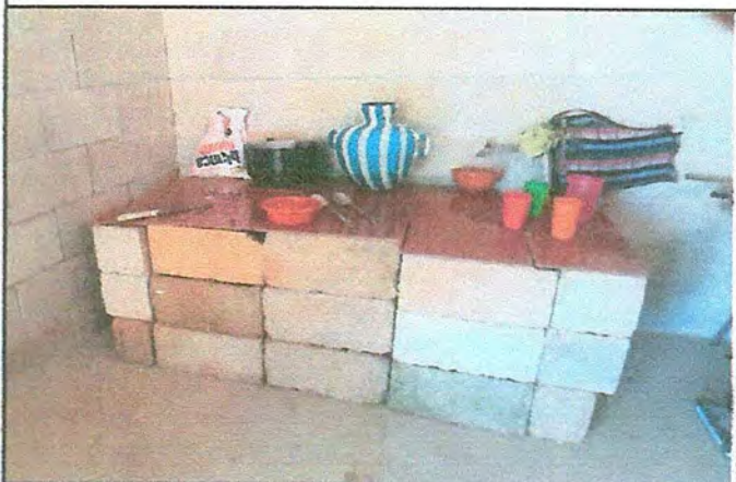
Foto 4: Sustrucción de Pila o deposito de agua
