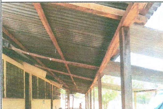
Foto 3: Mejoramiento estructura de techo del patio
