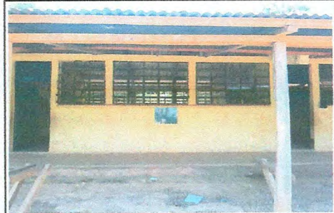
Foto 4: Mejoramiento cubierta de lamina patio
