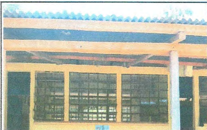
Foto 1: Mejoramiento de estructura de techo
