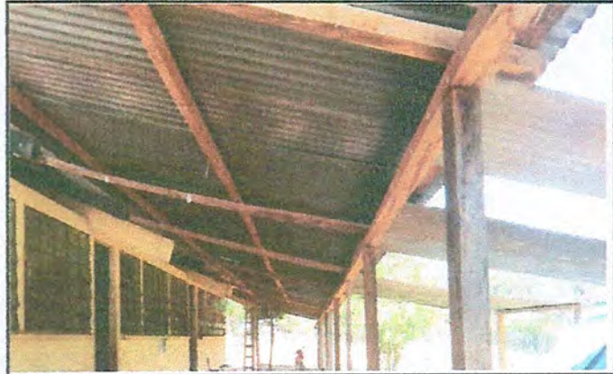
Foto 2: Cambio cubierta de lamina patio
