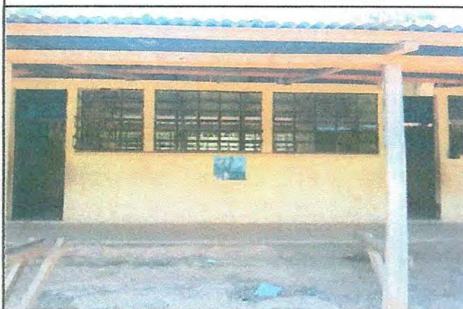
Foto 4: Patio frontal mejorara con losa de piso
