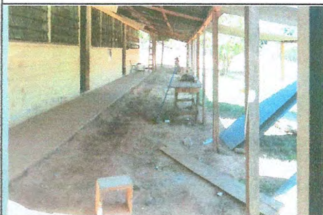
Foto 3: Patio mejorar con piso
