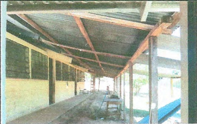
Foto 1: Cambio cubierta de lamina
