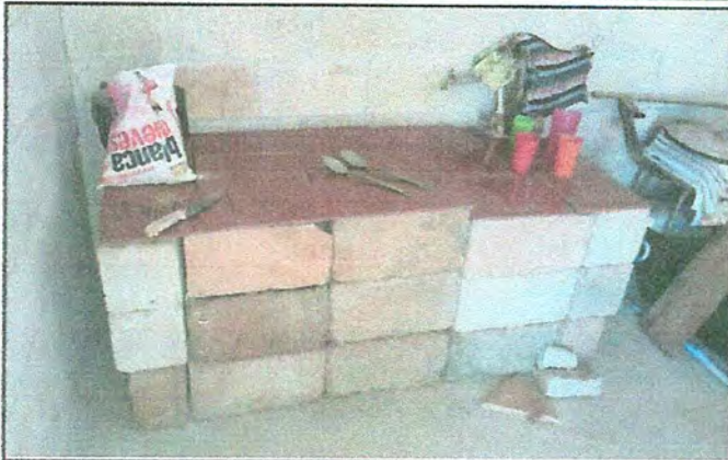
Foto 1: Sustrucción de lavatrastes, grifos y azulejos
