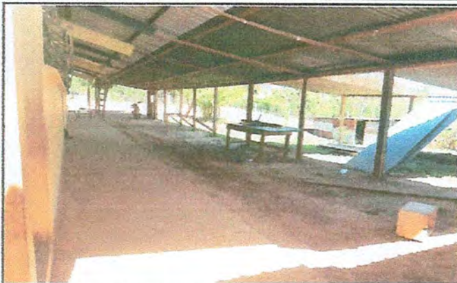
Foto 1: Mejoramiento de patio (aplanar)
